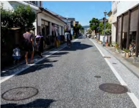
自然石アスファルト舗装は、石畳ではありませんが、石の素材感を感じやすい舗装です。(写真:日田市)
