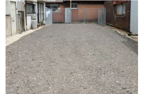
碎石敷きはアスファルトよりも環境にやさしくなります。(②維持管理)
