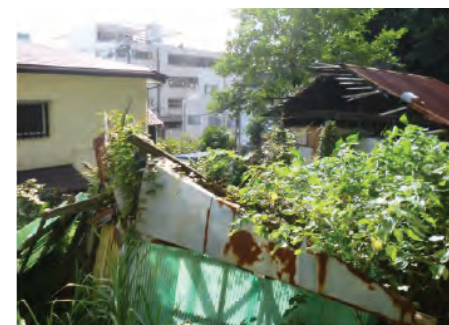
ゴミ等の撤去(③撤去・解体) 出典:国土交通省「行政が土地の利用・管理に関わる制度・事例」
