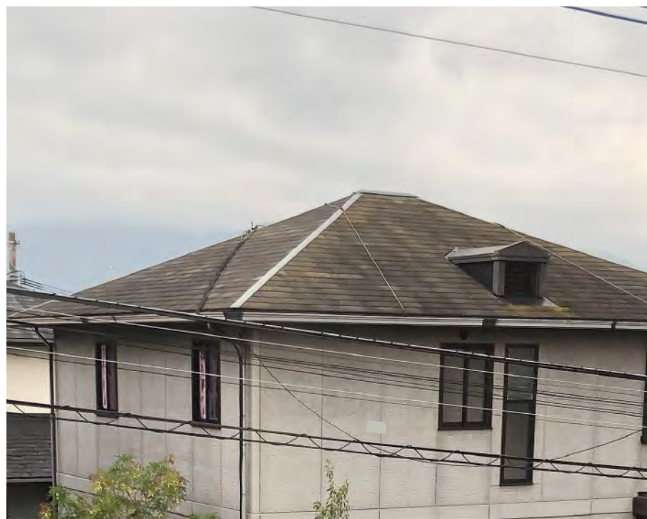
スレート屋根材は初期コストは安いものの、耐久性やメンテナンス頻度で瓦屋根やガルバリウム屋根に劣ります。
