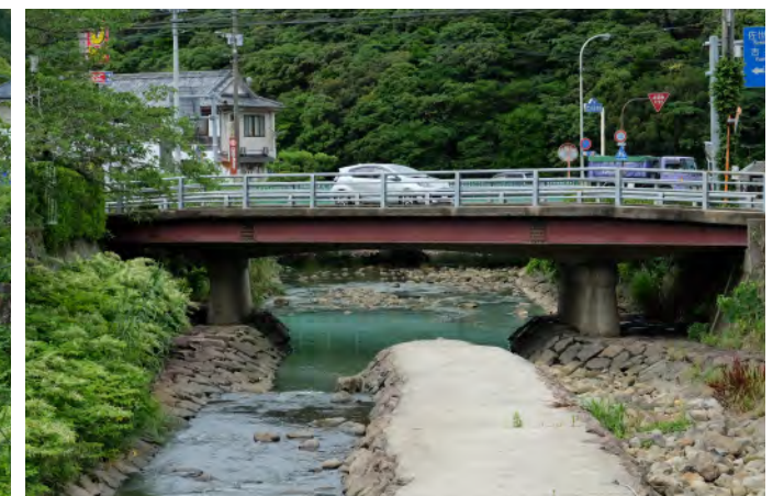
現在の鋼桁橋は素材・色彩に統一が見られず、エイジングしても自然に馴染んでいない印象があります。(写真中央の中洲の構造物は現在撤去され、懐かしい自然の川により近くなりました。)
