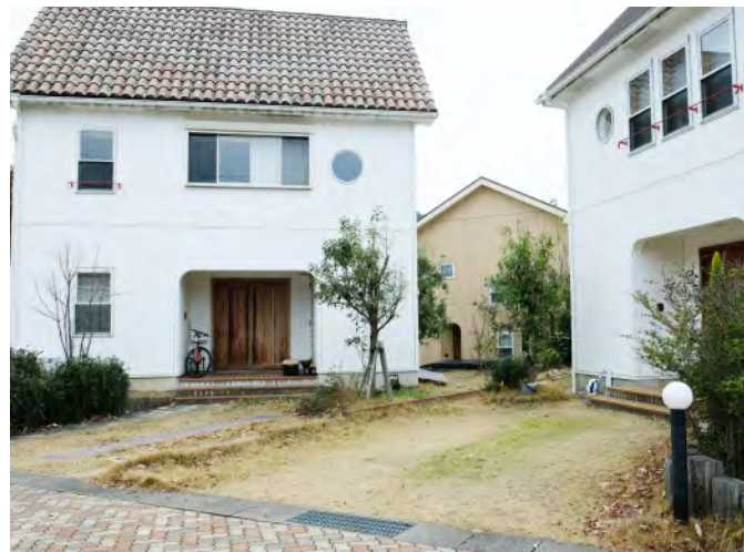
あえて塀を作らず、開かれた造りとする住宅。
